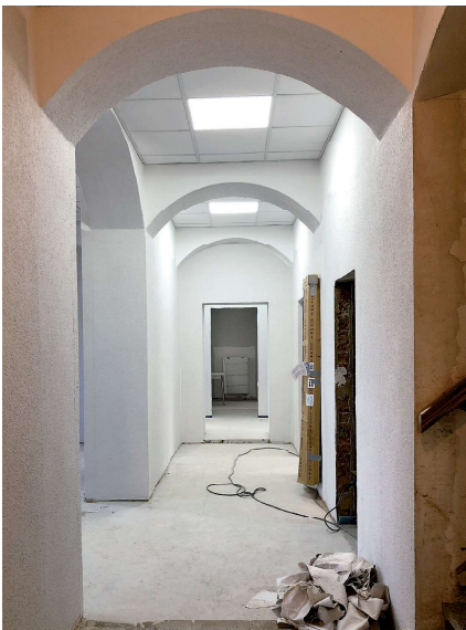
Der Fliesenboden musste weichen, Wände wurden neu verputzt.
