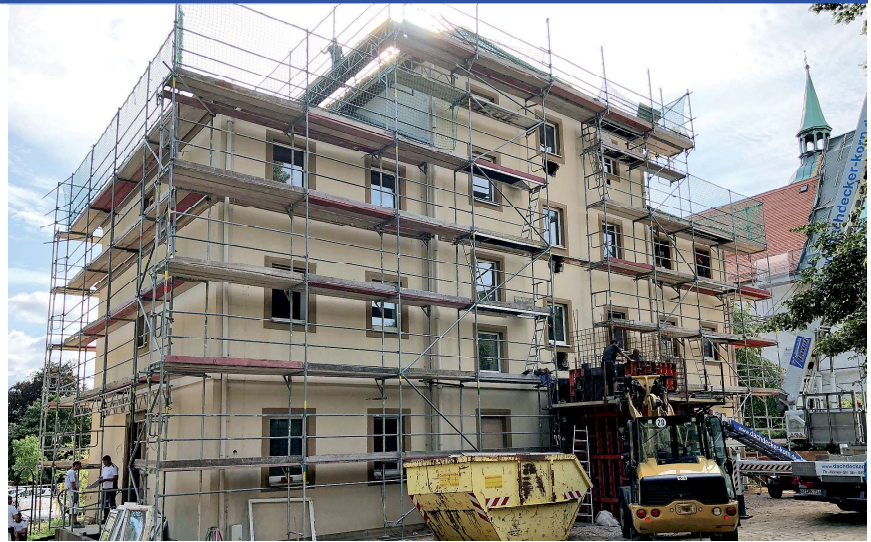
Entkernungsarbeiten am ehemaligen Gefängnisgebäude.
