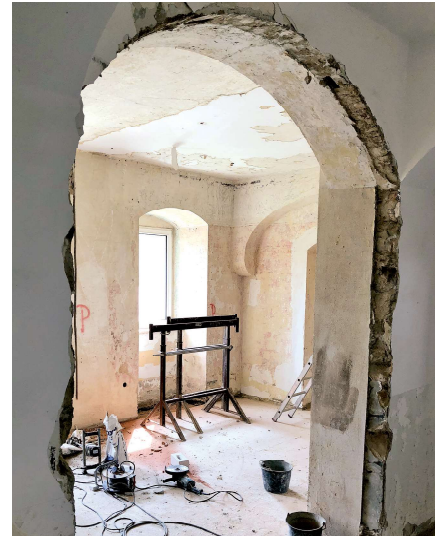
Ein Blick in den Rohbau während der Umbaumaßnahmen.
