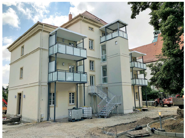
Endlich geschafft! Das „entrüstete“ Haus in der Brüderstraße 3a.
