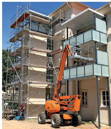
Die Balkone an der rückwärtigen Hausfassade werden installiert.
