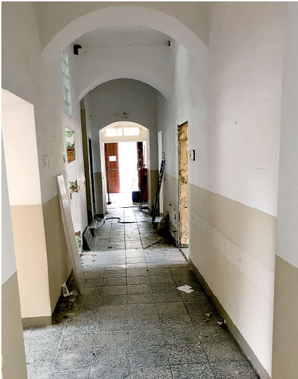
Die alten Zimmertüren wurden samt Zargen ausgebaut. Fotos: S. Petzold
