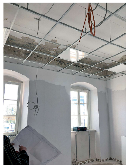
Vor dem Abhängen der hohen Decken wurden Elektrik und Medien verlegt.
