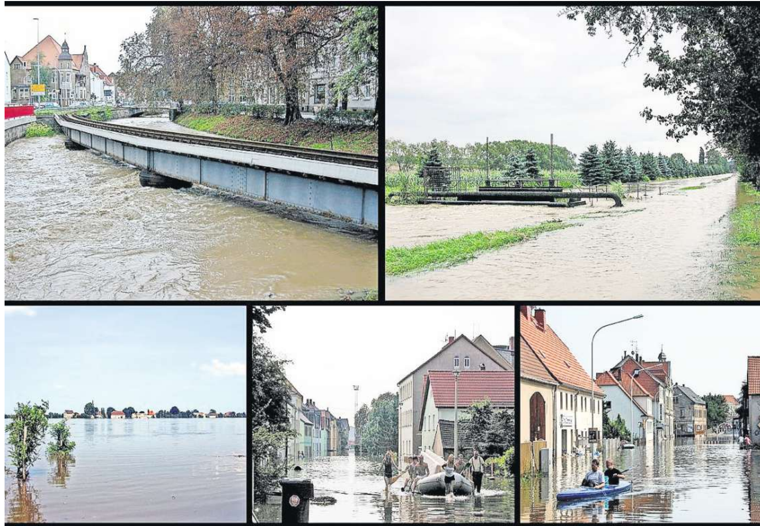
Die Döllnitz führte auch Hochwasser und erreichte mit dem Wasserpegel fast die Unterkante der Bahnbrücke unserer Schmalspurbahn in Oschatz (oben links). Auch der Dreibrückenweg in Oschatz wurde von den Wassermassen überspült. Auf dem Foto ist noch das alte Döllnitzwehr zu sehen (oben rechts). Viel schlimmer war die Lage im Bereich Strehla. Die Elbe stand in voller Breite zwischen Strehla und Lorenzkirchen und das Wasser reichte noch weit in das Hinterland. In Riesa waren die Straßen im Bereich des Hafens überflutet. Hab und Gut der Anwohner wurde auch mit Schlauchbooten in Sicherheit gebracht. Andere Anwohner nutzten ihr Faltboot für den Transport von Menschen und Sachen. FOTOS: JÜRGEN ALBRECHT
