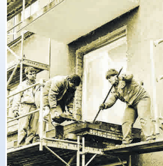
Die alten, verrotteten Balkone werden entfernt – Mügeln 1995
