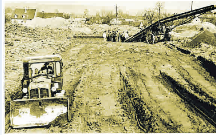
Ausschachten mit technischer Hilfe aus den Betrieben der Region in Mügeln 1960
