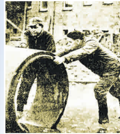
Eine Zeitung brachte 1962 dieses Bild vom Kampf mit den Betonringen für die Abwasserschächte und den Wetterverhältnissen im Herbst-Regen und Schlamm auf der Baustelle.
