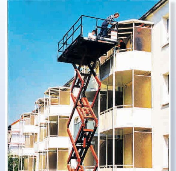
Balkon-Montage Mügeln. Neue Straße 1995 Fotos: Wohnungsgenossenschaft Oschatz/Mügeln eG
